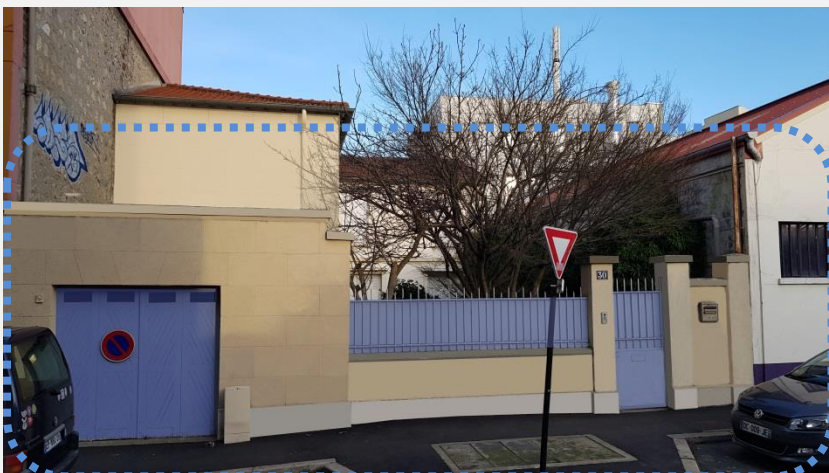
DP 06 Vue du mur de clôture et de la façade du garage – ETAT PROJETE
