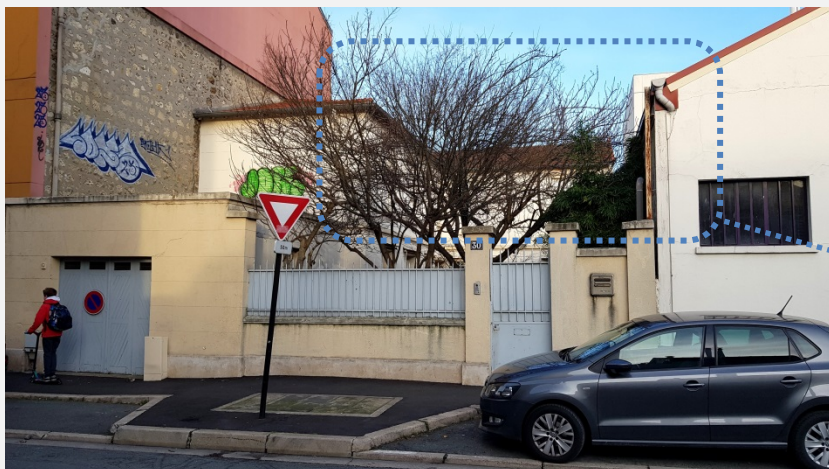
DP 07 Vue du bâti depuis la rue – ETAT EXISTANT
